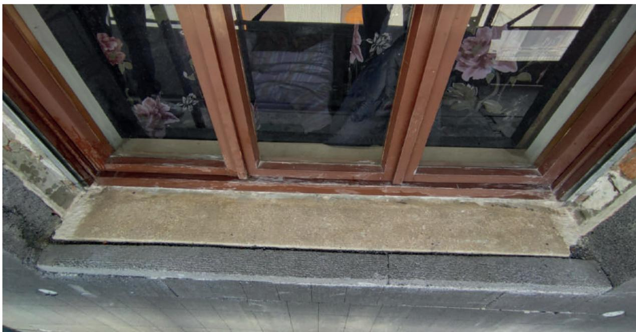
**2)** Stendere con l'apposita cazzuola dentata, uno strato di colla cementizia dello spessore minimo di 5mm sul vecchio davanzale.
